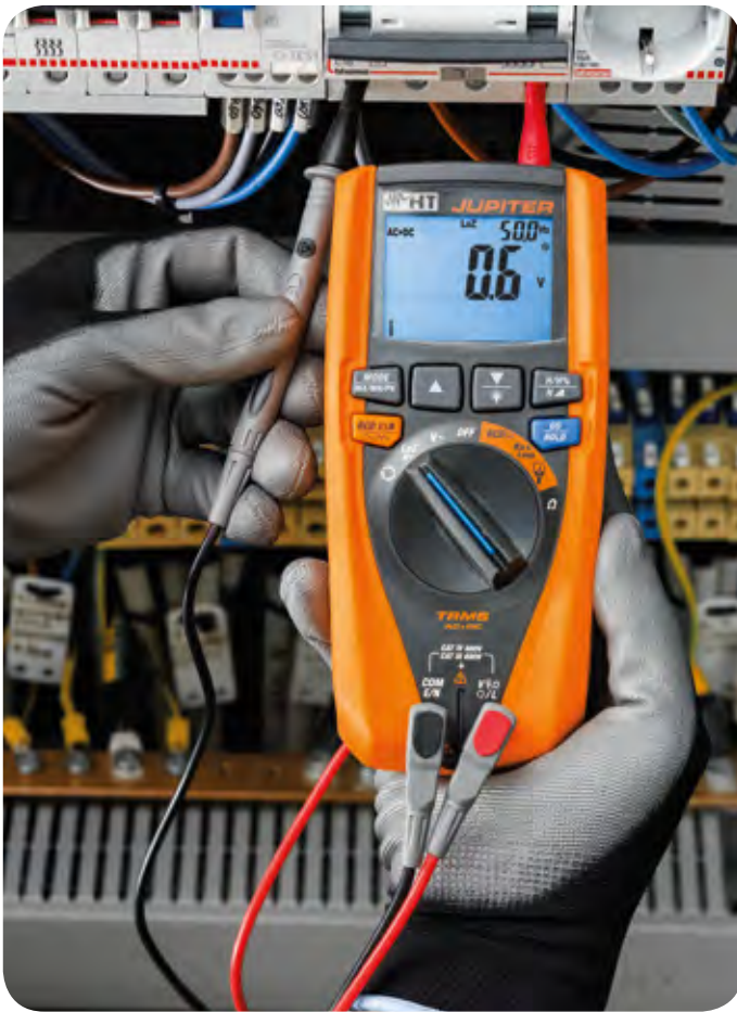
Remise à zéro des tensions parasites.
