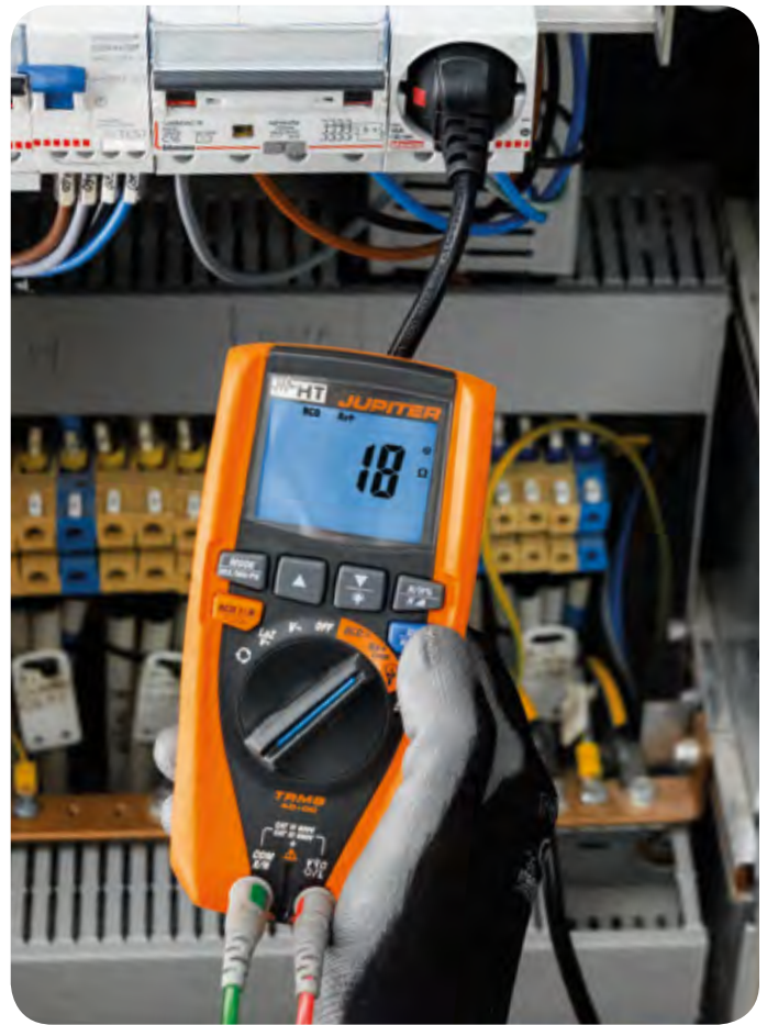
Mesure résistance globale de terre.
