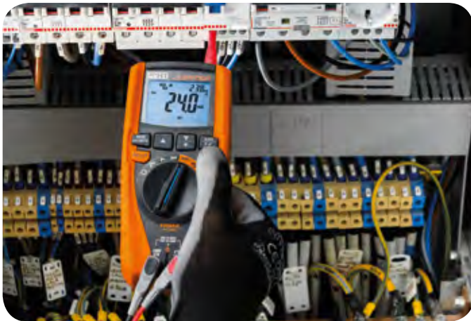
Vérification du temps de déclenchement des RCD.
