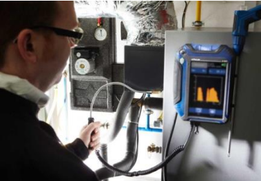
III. 48: Recherche de condensat pour contrôle du reflux
