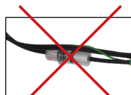
冷凝水槽 错误
