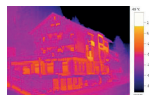
Image thermique avec testo ScaleAssist
