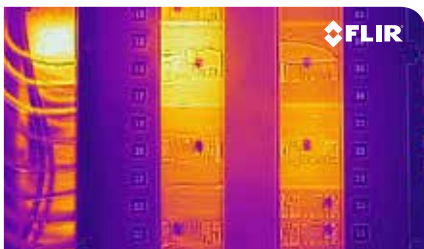
Connexion desserrée
