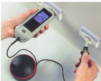
Contrôle de continuité entre prises
