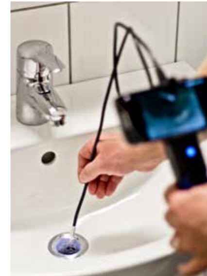
Inspection d'un lavabo avec Wöhler VE 200
